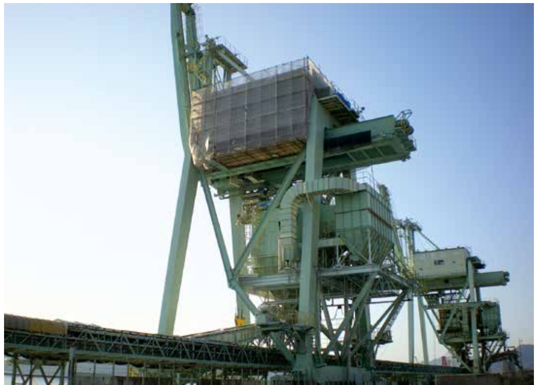
< 全農グリーンソース(株) アンローダー塗装工事 >
