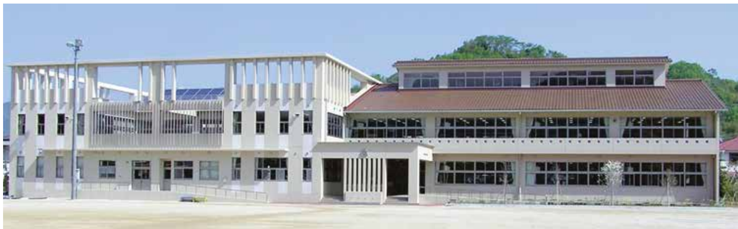
< 江田島市立 大古小学校新築塗装工事 >
