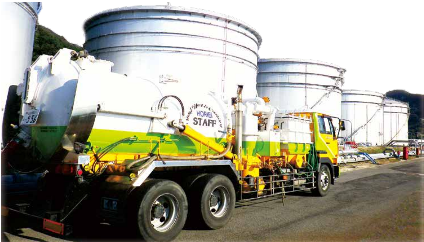
< 伊藤忠エネクス(株) タンク塗装工事 >
